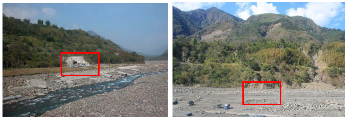
△左圖為曾文越域引水的勤和洞口，2005.12.17 攝；八八災後荖濃溪河床墊高，洞口已深埋於土石下 20 幾公尺，如何復工？
