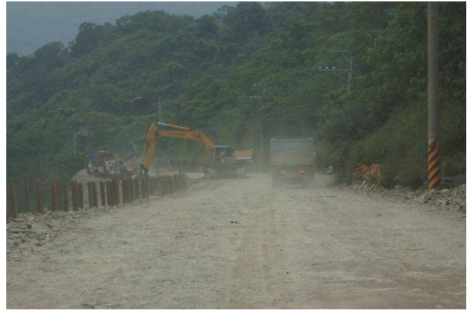
載運砂石的车運送到道路工程施工處。
