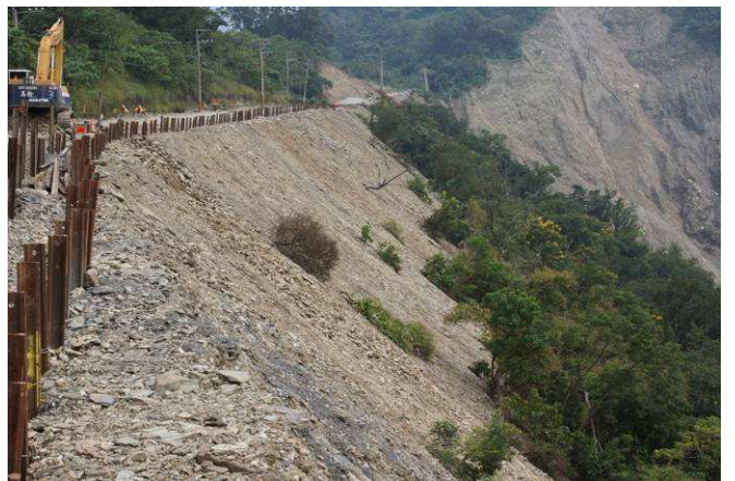
工地填地基的現況。
