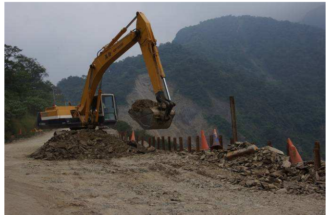
怪手將土石填充至路基。
