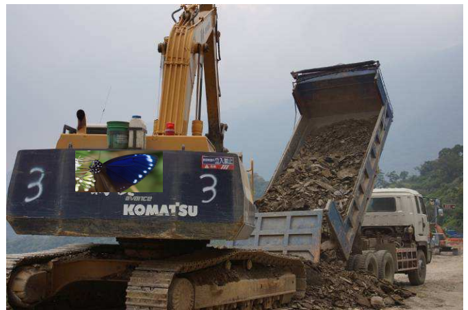
一車車從山頭挖來的砂石正堆至怪手的施工處。
