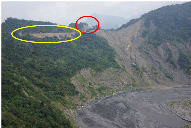
曲流上方的道路工程，黃線區域為道路施工處，紅線區是被挖砂石的山頭，此路段位於濁口溪的侵蝕坡上方。
